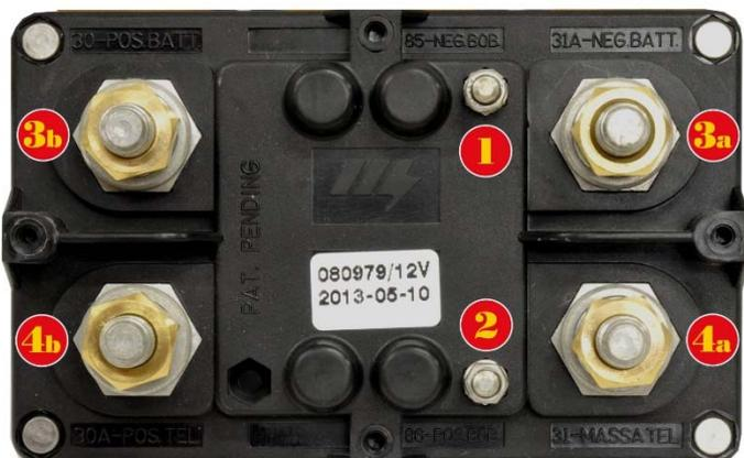
*Le gros Solénoïde Coupe-Batterie vu de dessus avec les bornes clairement identifiées. On peut utiliser au choix l'un ou l'autre côté des connecteurs « câbles de batterie »... 3a et 4a ou bien 3b et 4b. Ou même les deux en coupant à la fois le câble positif et le câble de masse. Ce qui est une précaution presque excessive.*
